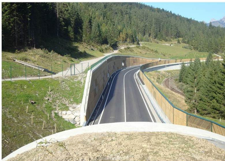
Umfahrung Heiterwang Lärmschutzwand und Lärmschutzpaneele
